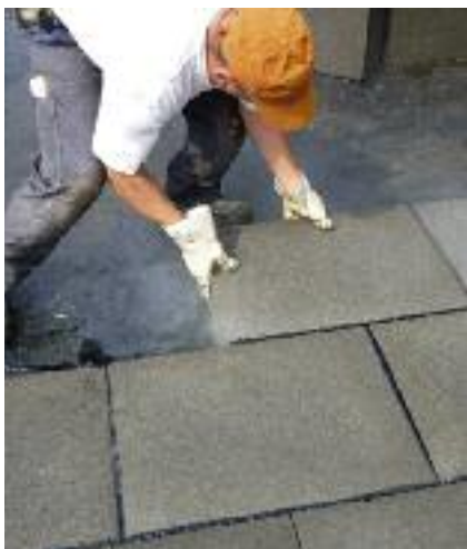
Alle Dachflächen erhielten eine Wärmedämmung aus FOAMGLAS®.
