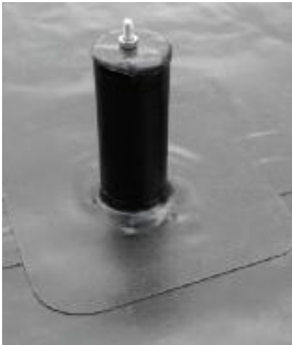
Bei den Dachdurchdringungen wie Sekuranten lieferte die Verlegeanleitung des Herstellers eine Vorlage.
