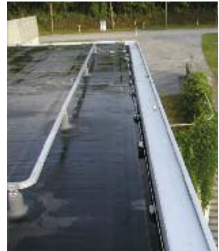
Dachfläche mit Kaltselfstklebebahn.
