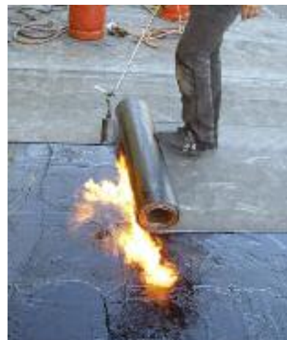
Aufflämmen einer Schweißbahn auf dem Deckabstrich.
