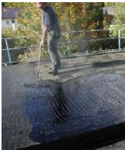
Aufbringen eines Deckabstrichs aus Heißbitumen.
